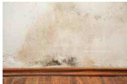
Apparition de moisissures sur un mur suite à une humidité excessive.
