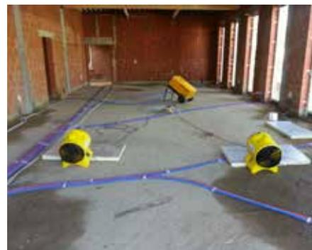
Exemple de dispositif pour ventiler et déshumidifier en cours de chantier.
