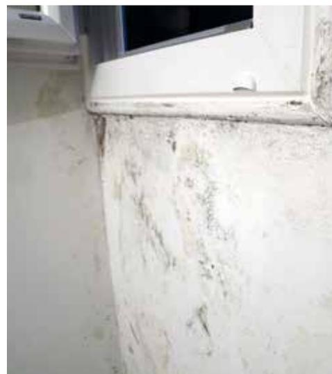
Apparition de moisissures dans une buanderie avec fenêtre non munie d'une entrée d'air.
