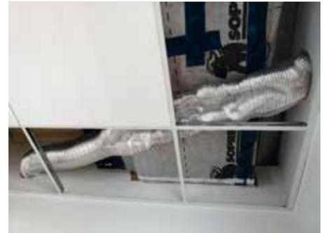
Mauvaise pratique : gaine souple écrasée lors de la mise en œuvre du faux-plafond.
